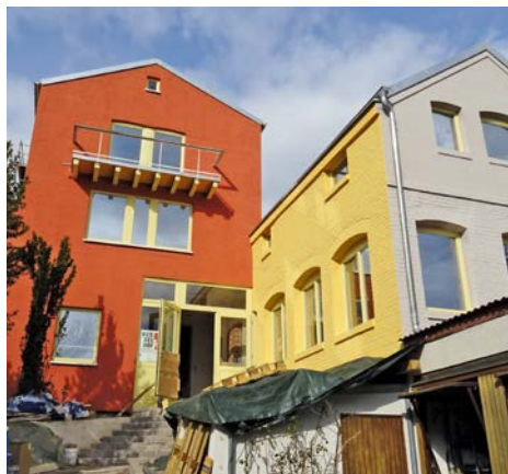
Der Baufortschritt im Kesselhof wird deutlich sichtbar – doch im Inneren gibt es noch viel zu tun.
