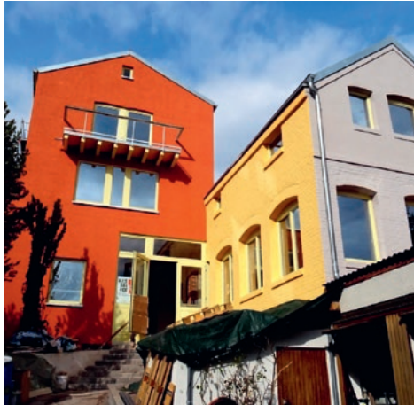
Der Kesselhof während der Sanierungsphase
