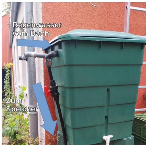
Unsere Sammeltonne, in der das Regenwasser zwischengespeichert wird, um es dann in den Speicher zu befördern. Die Pumpe sitzt am Boden der Tonne.
